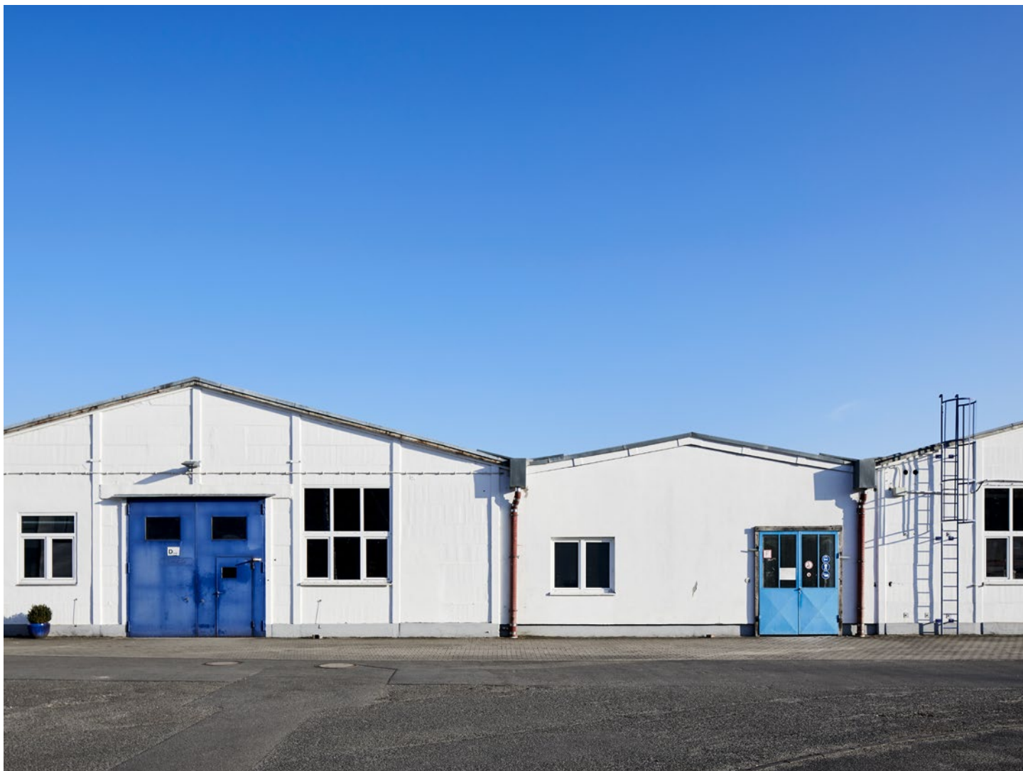
Außenansicht einer Lagerimmobilie Exterior view of warehouse property
